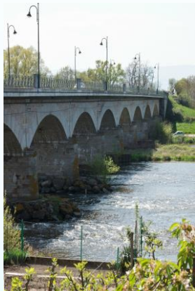
Le pont de Montrond-les-Bains 19ème siècle
